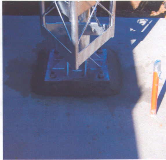
Fig 3 Correct conduit Positioning
